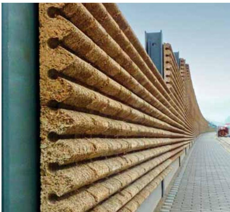
Vzhledem k vysokému výkonu se tento typ protihlukových stěn používá pro projekty, kde jsou hodnoty absorpce hluku „normálních“ protihlukových bariér nedostatečné. S tloušťkou 120 mm je tento hlukový absorbér s uzavřenou vlnovou strukturou výrobkem – uměleckým dílem, které nabízí maximální ochranu před zatížením škodlivým hlukem.
